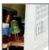
zielona dioda sygnalizująca pracę
